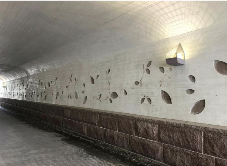
Keravan keskustan alueella risteilee useita alikulkuja. Panostus niiden suunnitteluun näkyy.
